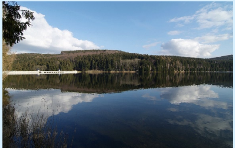
Die Talsperre Neunzehnhain liefert Rohwasser an die Talsperre Einsiedel, die Chemnitz mit Trinkwasser versorgt.
