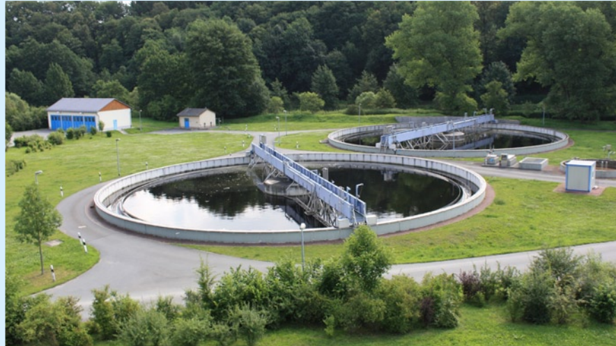
In den Nachklärbecken erfolgen die letzten Reinigungsschritte bevor das Wasser wieder in Flüsse oder Seen geleitet wird.
