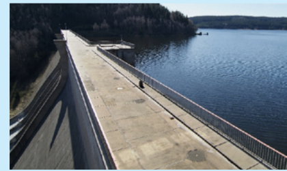
Staumauerkrone der Talsperre Eibenstock – Sachsens größter Wasserspeicher.
