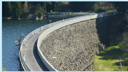
Die gekrümmte Gewichtsstaumauer der Talsperre Saldenbach ist begehbar.
