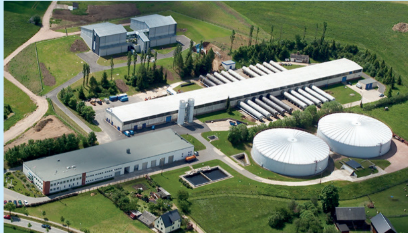
Das Wasserwerk Burkersdorf versorgt 600.000 Einwohner mit Trinkwasser. Rohwasserlieferant ist die Talsperre Eibenstock.
