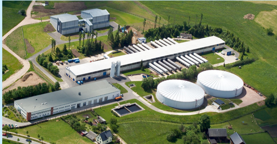
Das Wasserwerk Burkersdorf versorgt 600.000 Einwohner mit Trinkwasser. Rohwasserlieferant ist die Talsperre Eibenstock.
