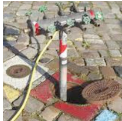
Unterirdischer Hydrant
