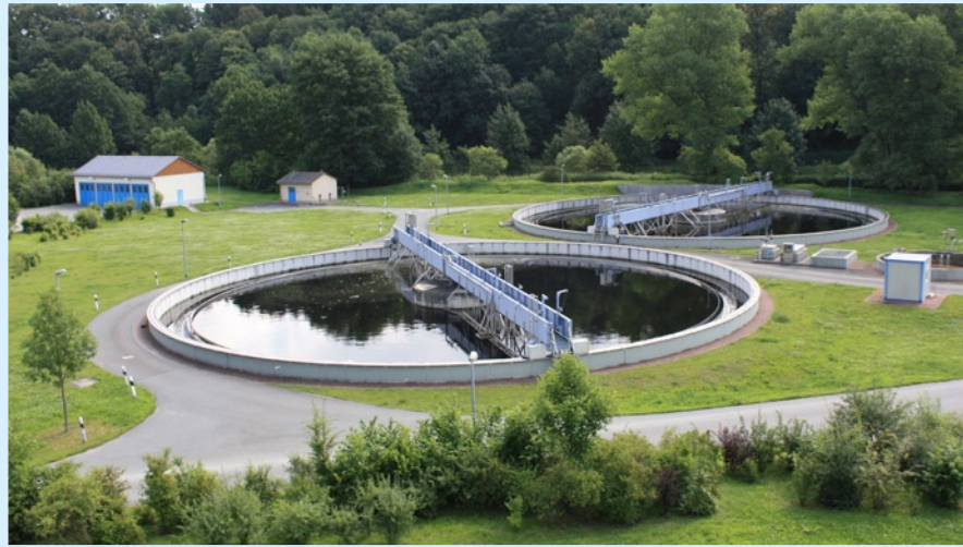
In den Nachklärbecken erfolgen die letzten Reinigungsschritte bevor das Wasser wieder in Flüsse oder Seen geleitet wird.
