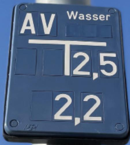
Das **blaue Schieberschild** weist auf Wasserrohre hin. Es zeigt, wo sich ein **Absperrventil** an der Trinkwasserleitung befindet.
