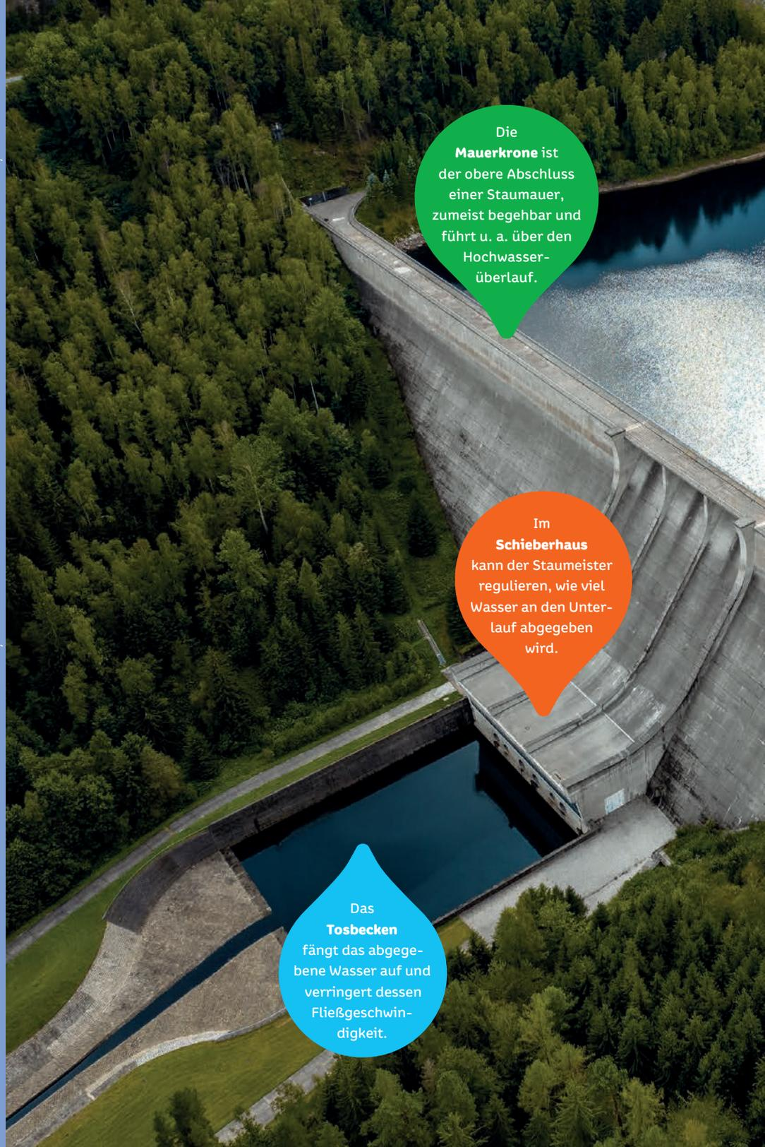
Die **Mauerkrone** ist der obere Abschluss einer Staumauer, zumeist begehbar und führt u. a. über den Hochwasserüberlauf.
